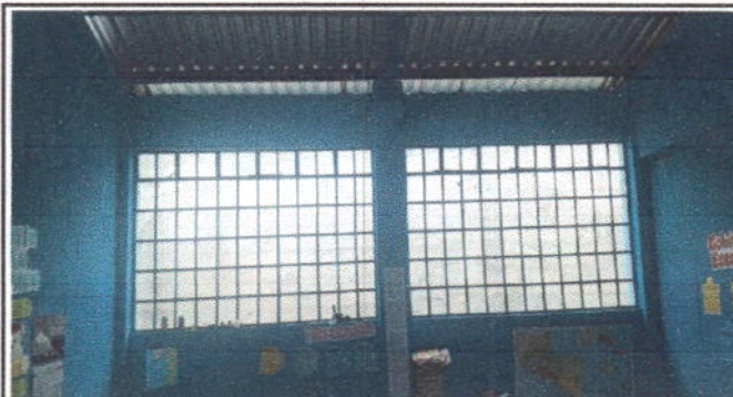
Foto 4: Aula numero 1 Sustitución de estructura de metal de ventana por PVC y balcones de metal,Modulo 2
