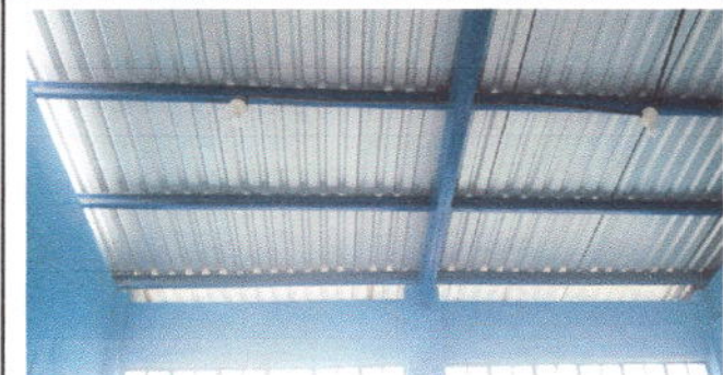
Foto 1: Aula numero 1 Sustitucion de estructura de soporte de metal por metal,Modulo 2
