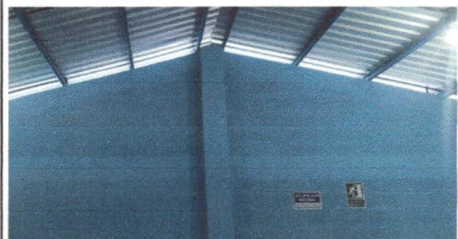
Foto 3: Cocina Sustitucion de estructura de soporte de metal por metal,Modulo 2
