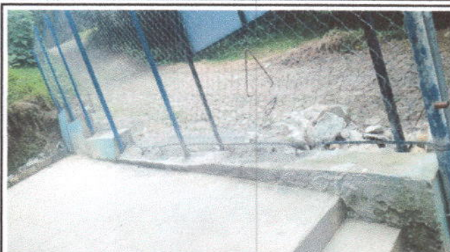
Foto 8: Reparación de muro perimetral, con tubo hg, soleras intermedias y columnas, Modulo 2
