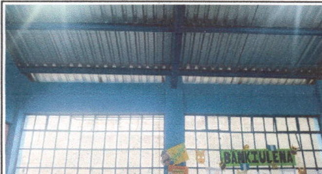
Foto 2: Aula numero 2 Sustitucion de estructura de soporte de metal por metal,Modulo 2
