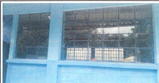
Foto 5:Aula numero 1 Sustitución de estructura de metal de ventana por PVC y balcones de metal,Modulo 2
